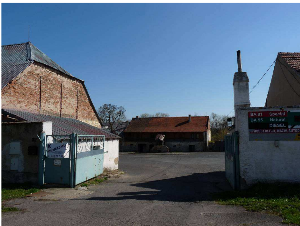
Obr.17 Pohled na vjezd do velkého statku, kde se nyní mimo jiné nachází čerpací stanice
