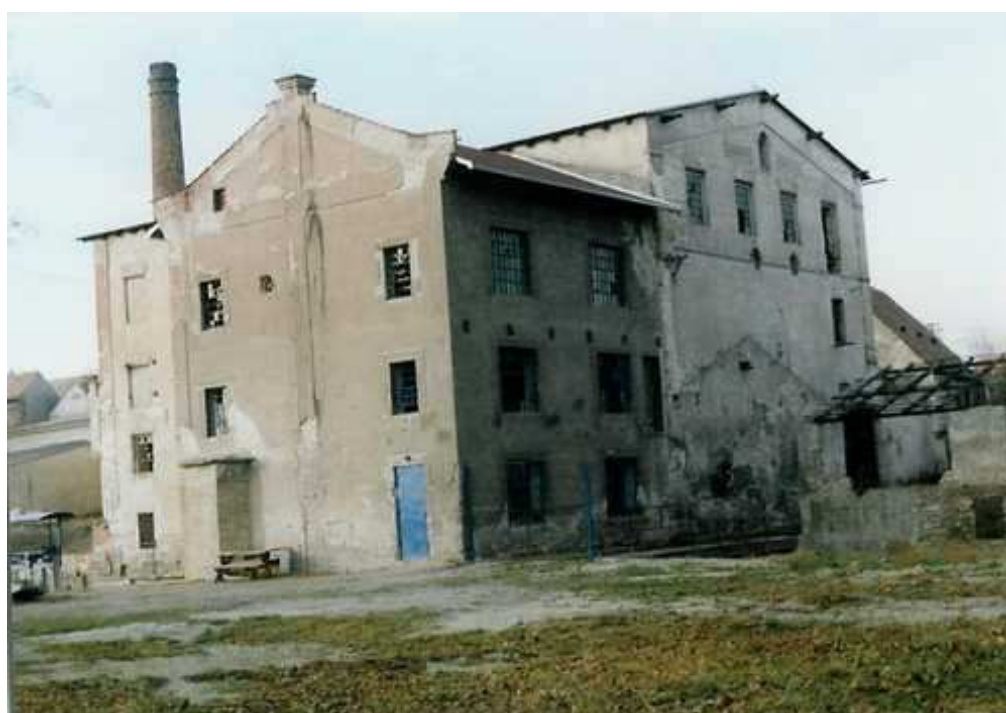
Obr.4 Ortův mlýn před rekonstrukcí
