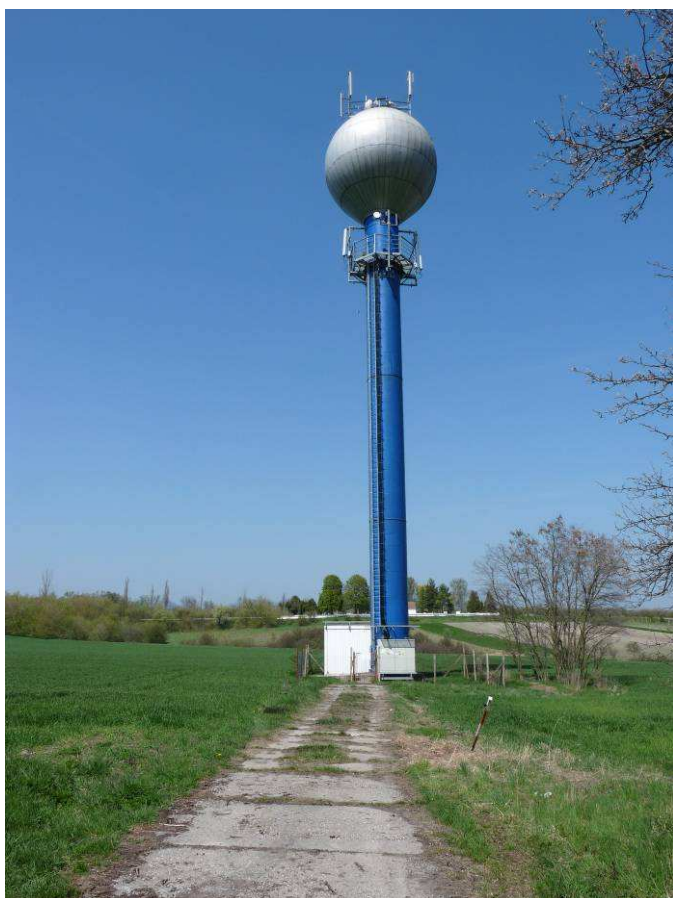
Obr.19 Vodojem v západní části obce směrem do chatové oblasti Dobročka
